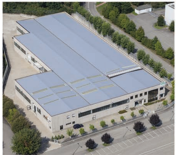
FAR - Stabilimento di San Maurizio d'Opaglio (NO)
